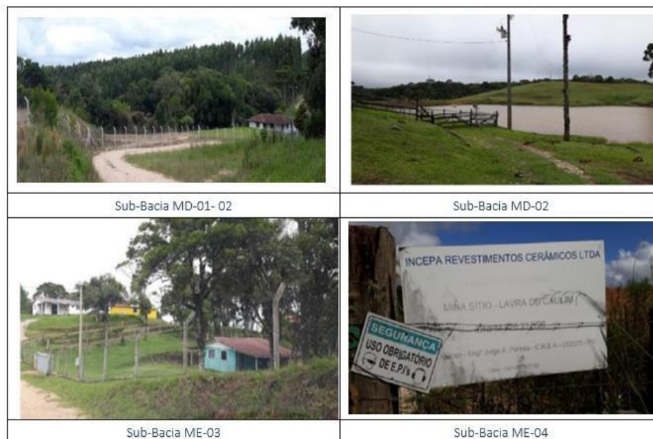
Figura 11 - aspectos das sub-bacias na área de construção da barragem do miringuava
