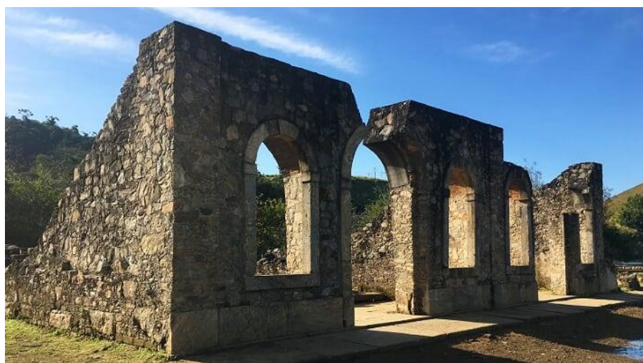
Figura 21- Anastilose concluída, vendo-se os contrafortes construídos para estabilização das fachadas
