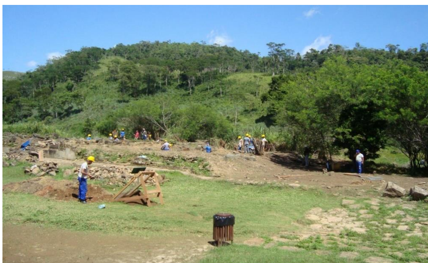
Figura 8 - Vista do terreno onde estava edificado o sobrado após o desmatamento
