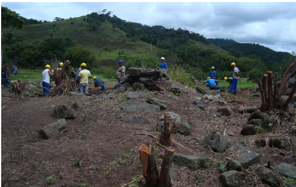
Figura 9 - Arbustos já parcialmente cortados e peças de cantaria da edificação
