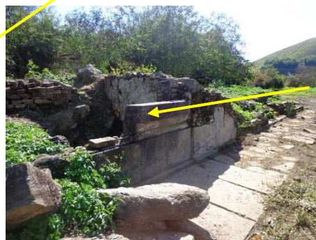
Unidade 2: soco e peitoril do vão da janela.
