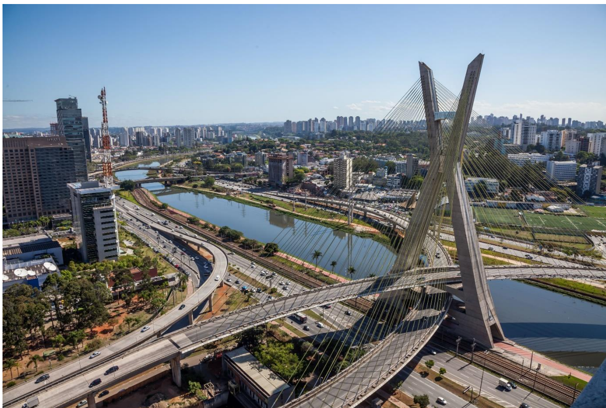
Fig. 01 A infraestrutura de transporte rodoviário. A ponte Octavio Frias de Oliveira em São Paulo (2008), tem sido um ícone de progresso e modernidade ao longo do tempo
