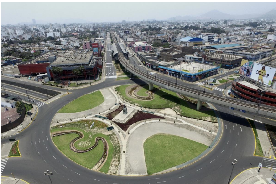
Fig. 07 Vista do viaduto da linha 1 do Metrô de Lima ao passar pela oval da Higuiereta
