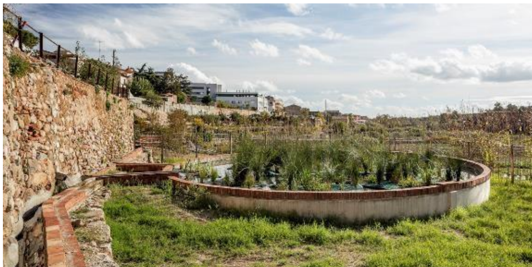
Figura 36 - Imagen de la balsa de riego con sistemas de fitodepuración flotante en el Jardín de la Huerta Termal en Caldes de Montbui. Autor: Adrià Goula.
