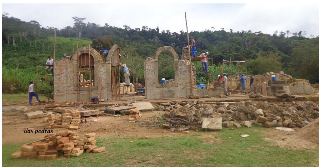
Figura 18 - Execução da anastilose do sobrado, vendo-se trecho da fachada da Unidade 1
