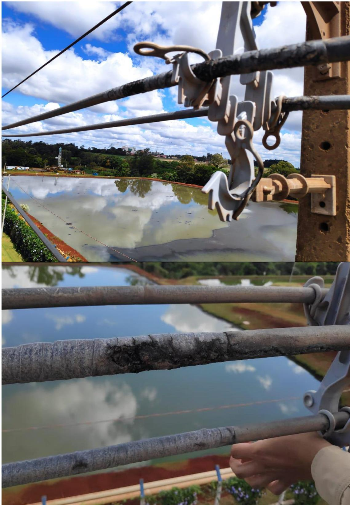
Figura 14 – Fotografia de trecho de linha compacta de 35 kV degradada por trilhamento elétrico
