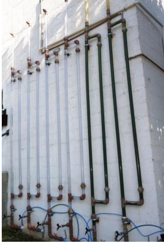
Figura 7 - Fotobiorreatores airlift utilizados no NPDEAS.
