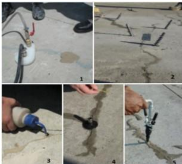
Figura 2: Técnicas de injeção de calda coloidal de microcimento
