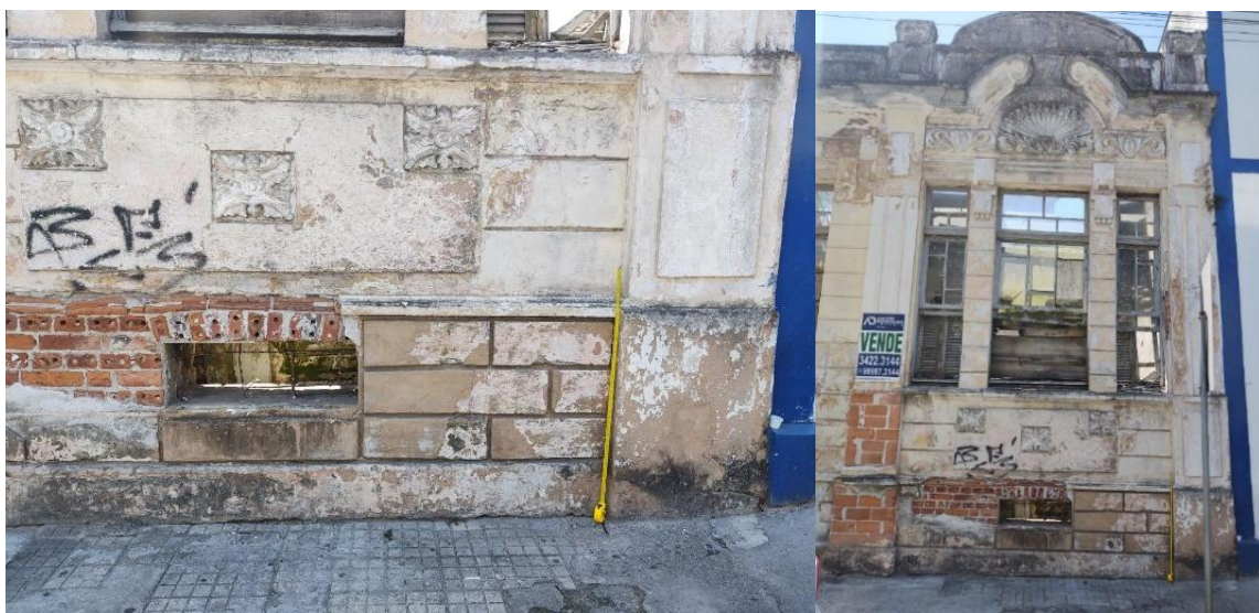
Figura 1: Foto de fachada com trena
