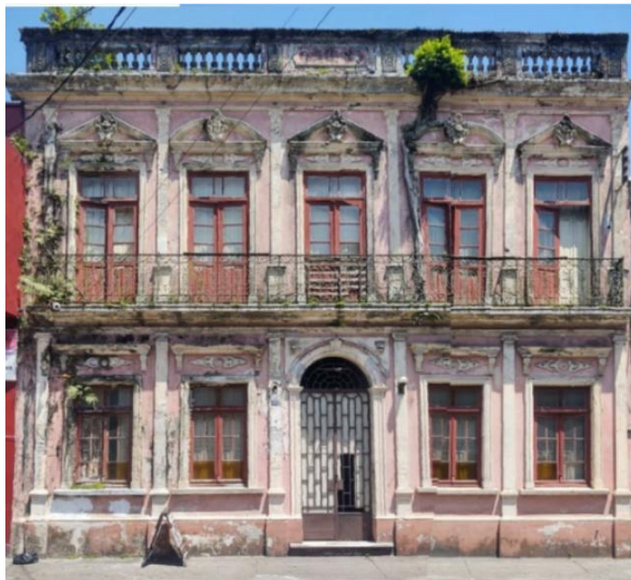
Figura 5: Foto de fachada após o tratamento e planificação
