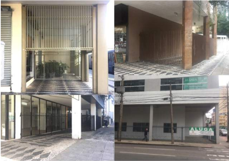
FIGURA 15 - Fechamento das galerias em lotes de esquina
