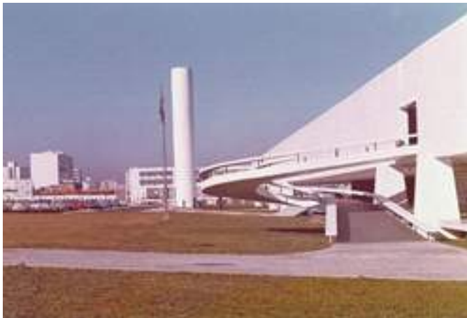
FIGURA 02 - Edifício Humberto Castello Branco – Oscar Niemeyer – Década de 1970
