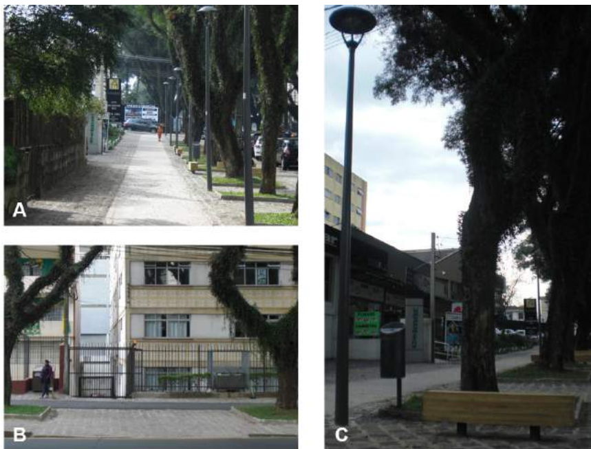
FIGURA 09 - Revitalização das calçadas da Av. Getúlio Vargas. A) melhoria na acessibilidade: implantação de faixa de concreto moldado in loco na calçada do lado esquerdo da via; B) regularização das lixeiras: com as obras de revitalização, os condomínios foram notificados sobre a sua posição irregular; C) implantação de novo mobiliário: bancos, lixeiras e luminárias para os pedestres
