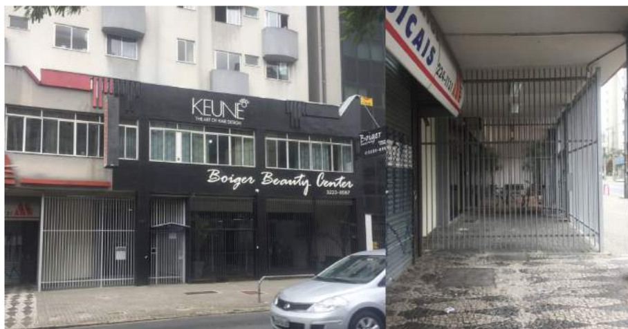
FIGURA 14 - Gradeamento das galerias em acessos residenciais
