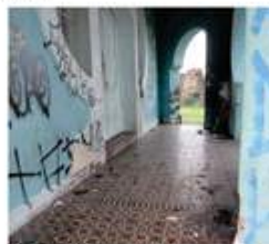
Figura 7f Detalhe interno do Belvedere
