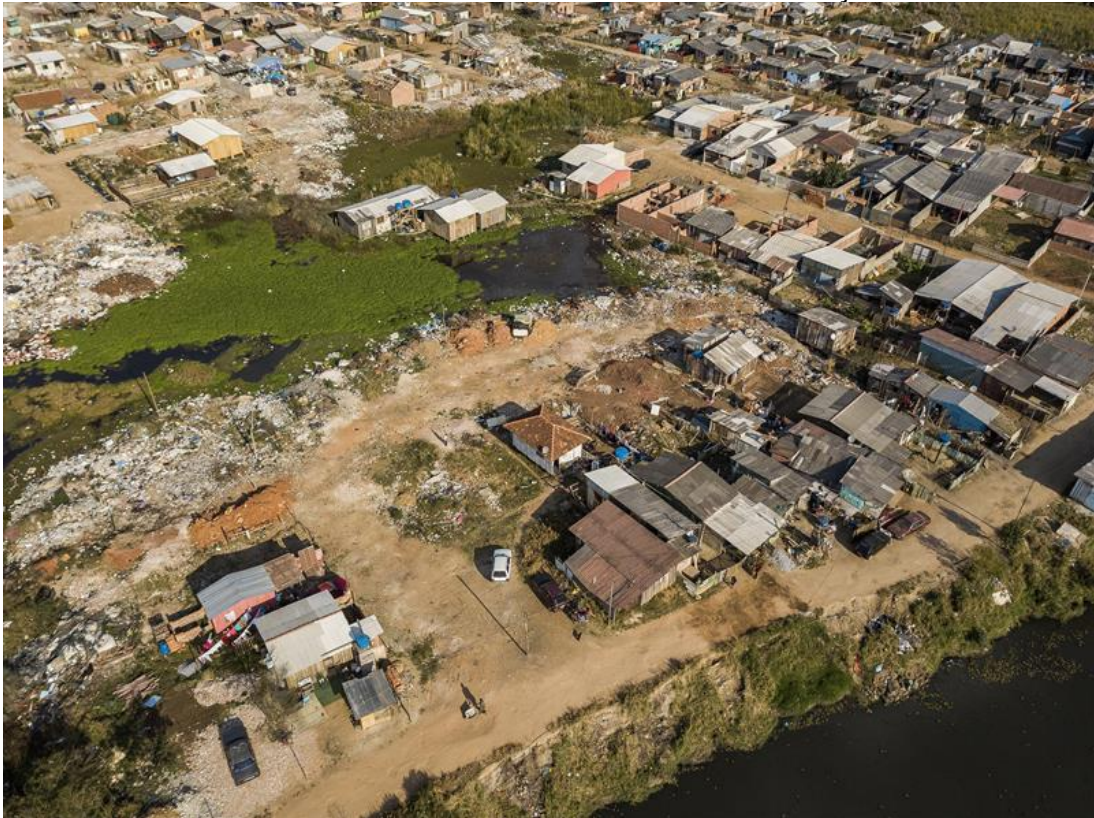
FIGURA 15 – FOTO AÉREA DE PARTE DAS OCUPAÇÕES
