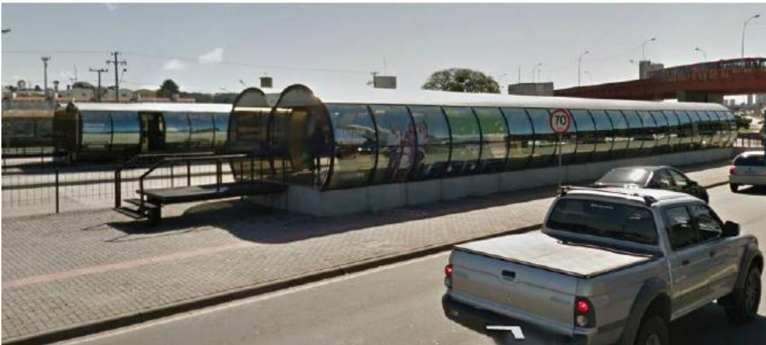
Figura 7: Parada de ônibus na Av. Marechal Floriano, em Curitiba. Fonte: GOOGLE MAPS, 2014.
