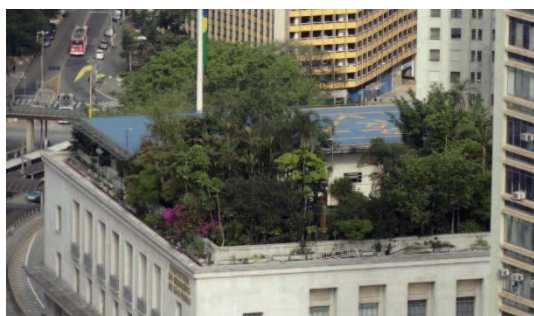
Figura 02: 03. Edifício Conde Matarazzo, São Paulo, Brasil. Fonte: Marcelo Piacentini (1939).
