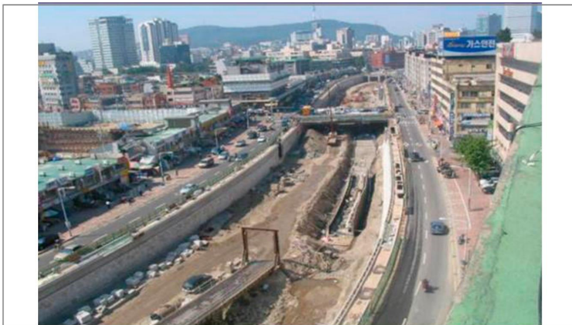
Figura 40 – Progresso das obras de restauração do rio Cheonggyecheon.
