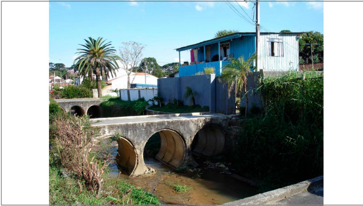
Figura 22 - Ocupações irregulares avançando sobre as margens do rio Belém, bairro Barreirinha.
