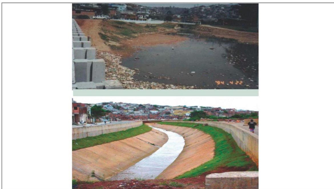
Figura 63 – Medidas estruturais executadas – bacia de retenção (foto superior) e canalização (foto inferior).
