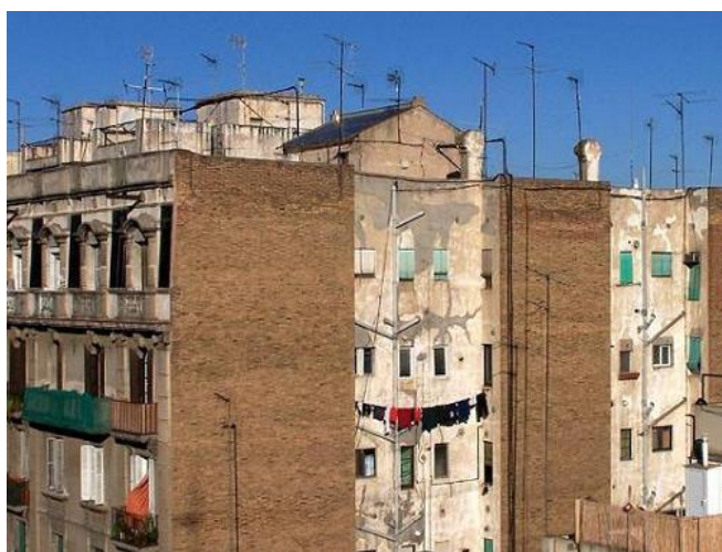
FIGURA 9 – EDIFICAÇÕES NO BAIRRO EIXAMPLE DIREITO
