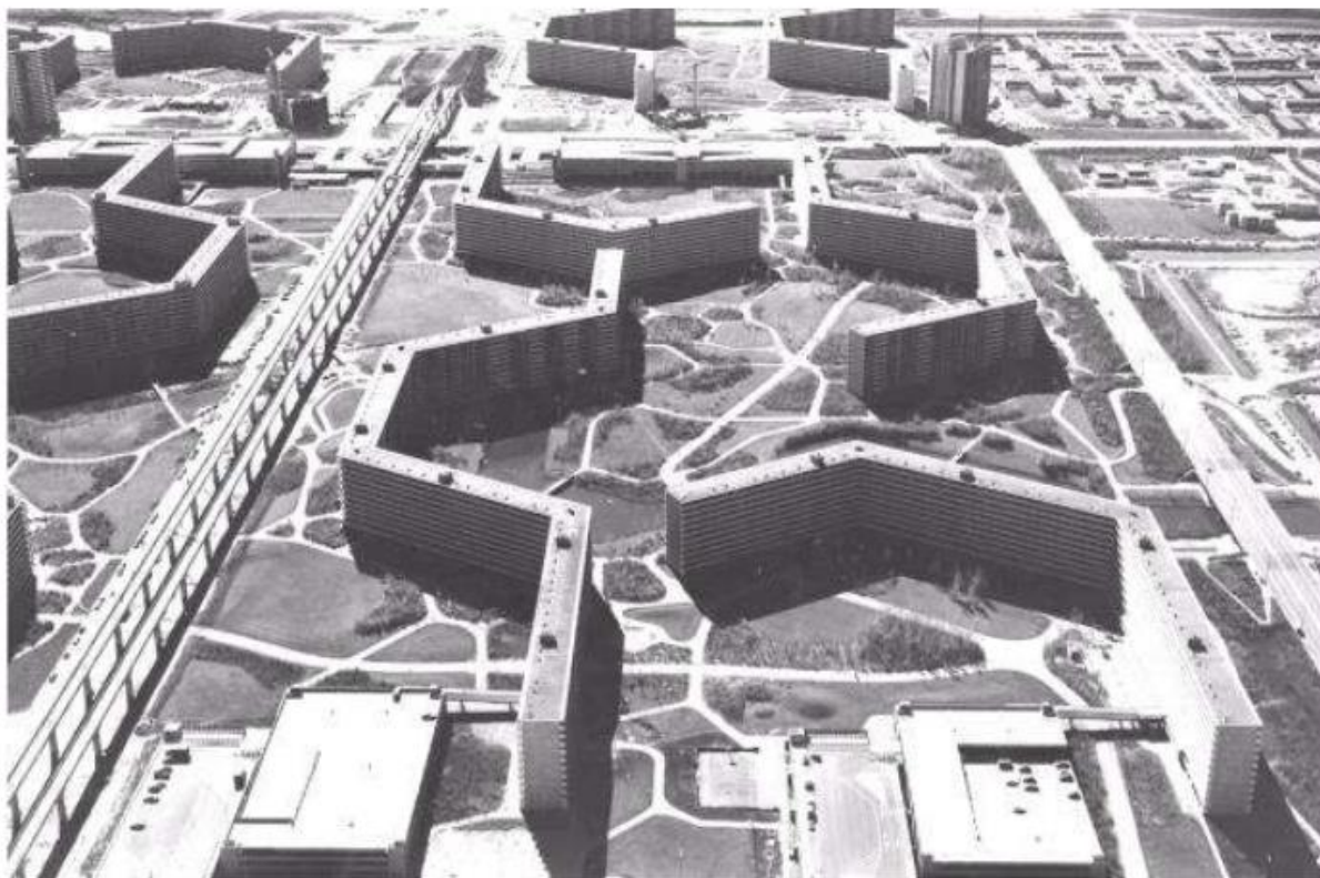
Figura 5- Vista aérea do Bijlmermeer
