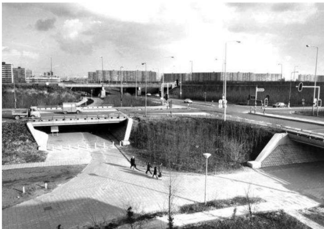
Figura 6 – Separação das vias de veículos e pedestres
