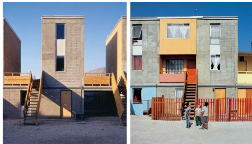
FIGURA 13 – COMPARAÇÃO DO EXTERIOR DA EDIFICAÇÃO ANTES E DEPOIS DAS EXTENSÕES – QUINTA MONROY FONTE: (FRACALOSS, 2013)
