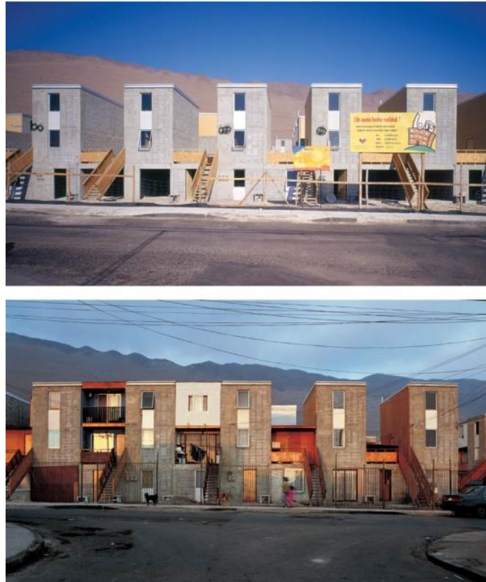
FIGURA 9 – EDIFICAÇÃO ANTERIORMENTE Á EXPANSÃO E COM A EXPANSÃO – QUINTA MONROY. FONTE: (FRACALOSSO, 2013)
