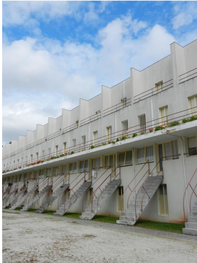
FIGURA 23 – CONJUNTO HABITACIONAL BOUÇA FONTE: A autora, 2012
