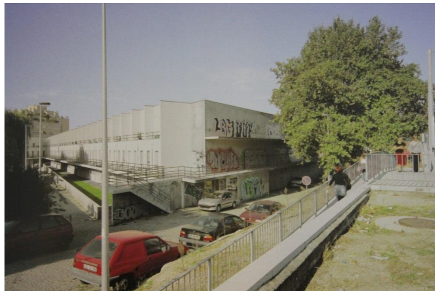
FIGURA 21 –FACHADA PARALELA À LINHA DE METRÔ - BOUÇA FONTE: (ALVARO SIZA, 2008).
