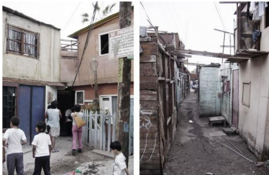
FIGURA 01 –ASSENTAMENTO DA QUINTA MONROY ANTES DA INTERVENÇÃO FONTE: (PLATAFORMA ARQUITECTURA, 2013).
