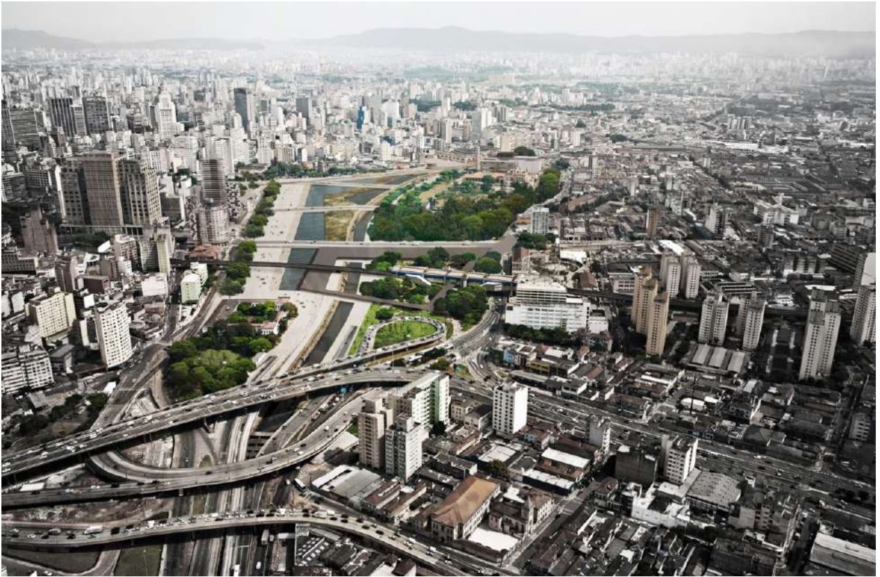
FIGURA 32 – SITUAÇÃO DA ÁREA APÓS A INTERVENÇÃO.
