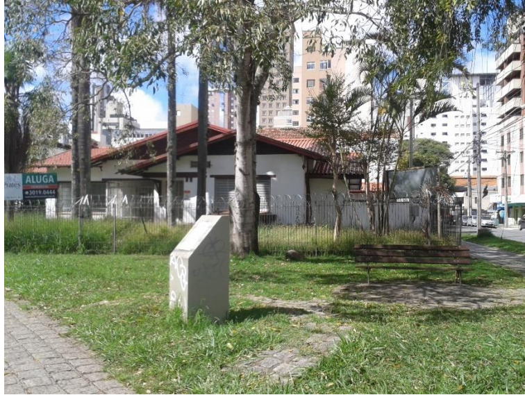
FIGURA 3.17: Imagem de residência vazia em frente a um jardimete na Rua Professor Fernando Moreira.
