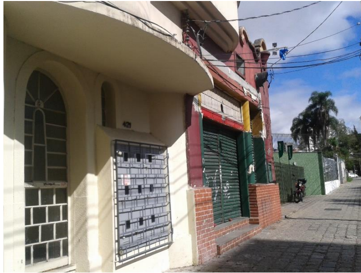
FIGURA 3.14: Vista de edificações na Rua Professor Fernando Moreira ao nível dos olhos do pedestre.
