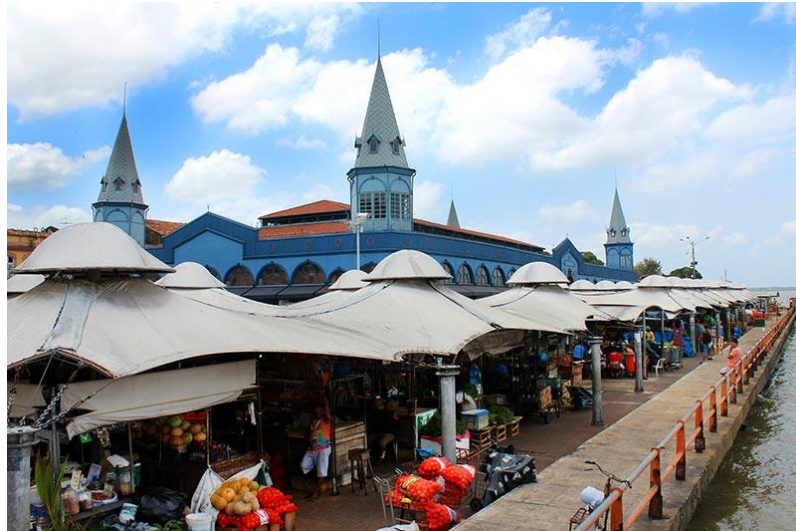
FIGURA 4.13: Vista da cobertura tensionada da feira do Complexo “Ver-o-Peso”.
