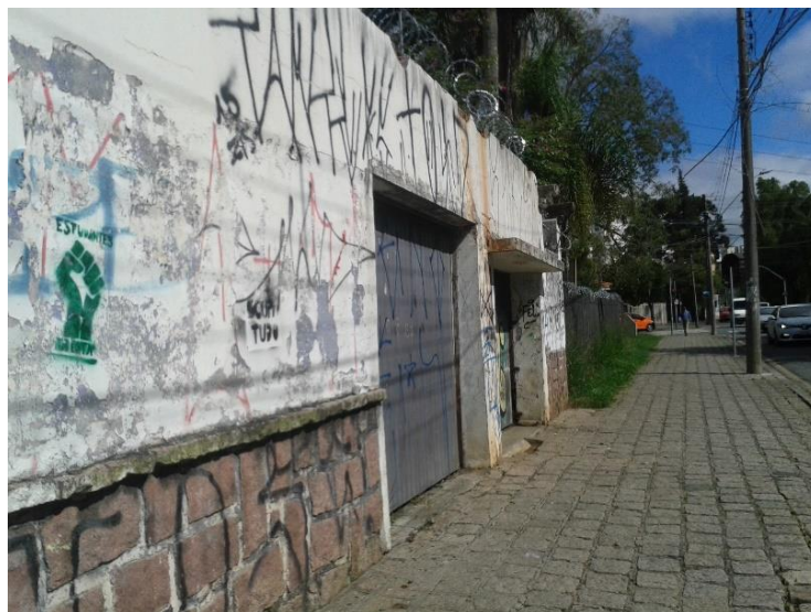
FIGURA 3.15: Vista de edificações na Rua Professor Fernando Moreira ao nível dos olhos do pedestre.
