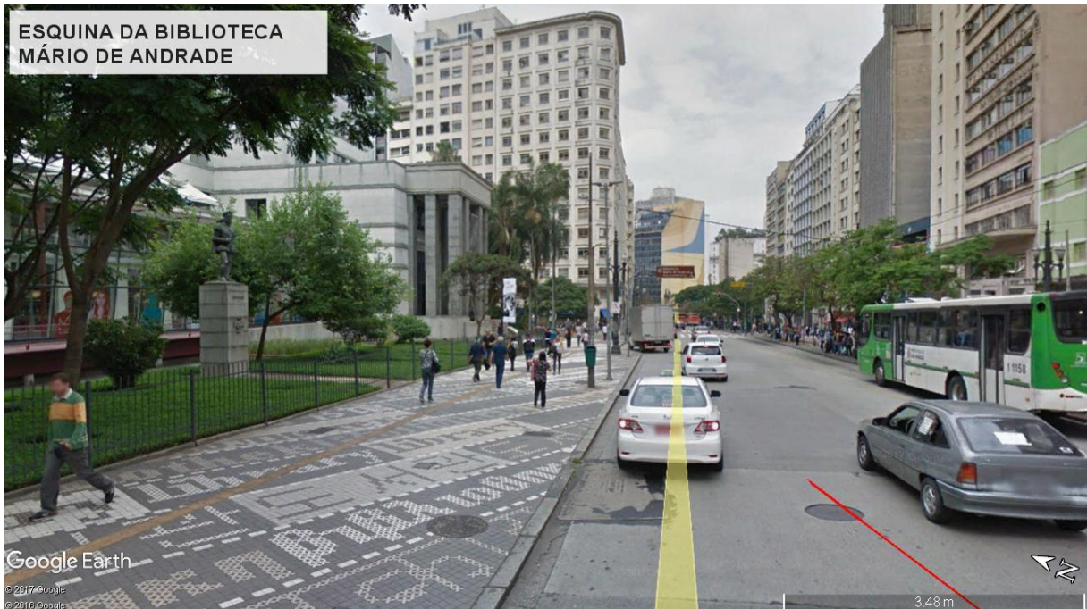
FIGURA 4.23: Vista da Biblioteca Mário de Andrade, na Rua Xavier de Toledo.
