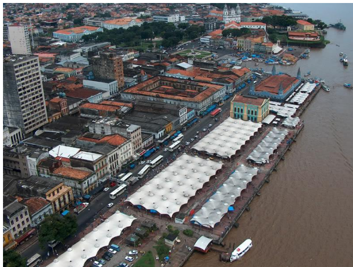
FIGURA 4.12: Vista aérea da cobertura da feira do Complexo “Ver-o-Peso”.
