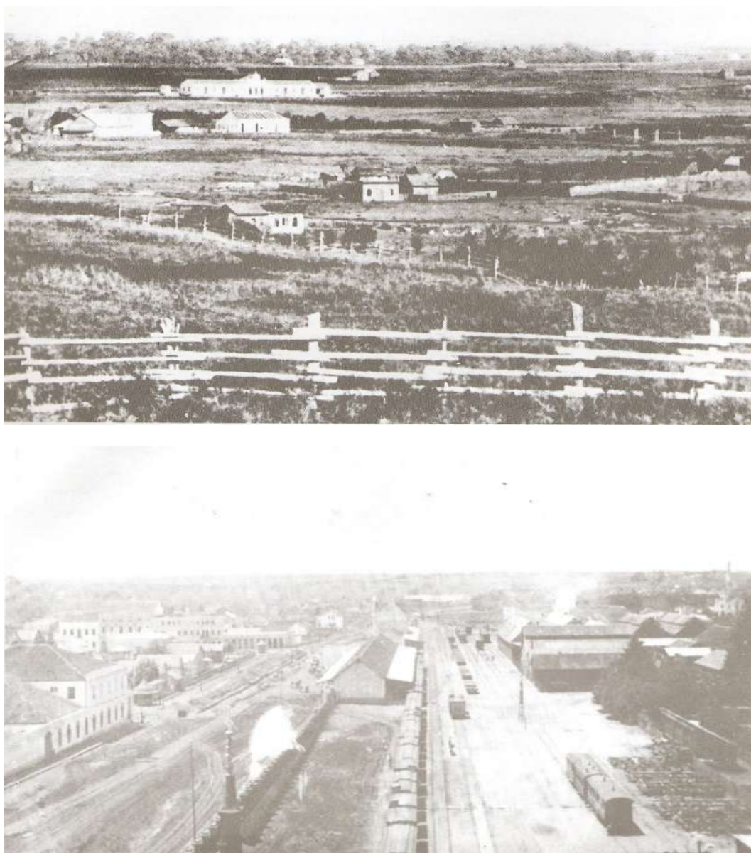
FIGURA 3 – TRANSFORMAÇÃO DA PAISAGEM A PARTIR DA IMPLANTAÇÃO DA ESTAÇÃO FERROVIÁRIA, LOCALIZADA RESPECTIVAMENTE AO FUNDO (1883) E AO CENTRO (1904) FONTE: FENIANOS (2002)
