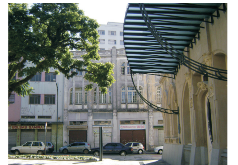
Paço Municipal revitalizado e edificações deterioradas. (Fonte: a autora, 2009)
