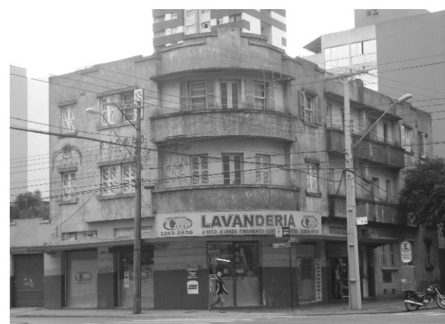
R. Mariano Torres: edificação deteriorada. Fonte: Lilian Ferri, 2009. É possível verificar, em diversos locais, edificações e espaços públicos depredados e deteriorados.
