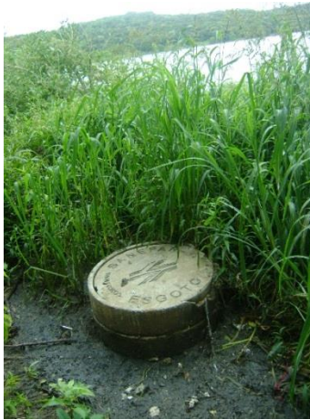
Figura 4 - Situação de fragilidade da RCE as margens do reservatório de abastecimento Fonte: AUTOR 2016
