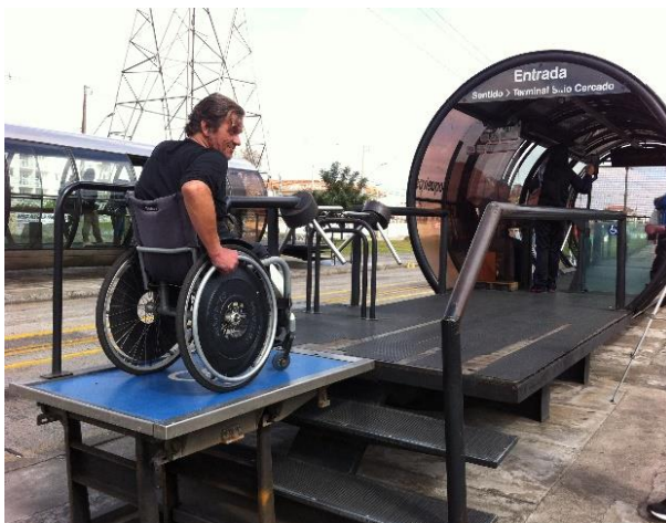
Figura 2 – Plataforma elevatória para acessibilidade diferenciada na entrada da Estação-Tubo Coqueiros
