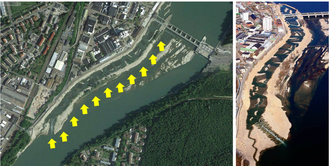
Figura 7.10 – Plataforma construída em caráter provisório, mas mantida após concluídas as obras. Vista de cima (a) e em perspectiva, com a escada de peixes em primeiro plano (b)
