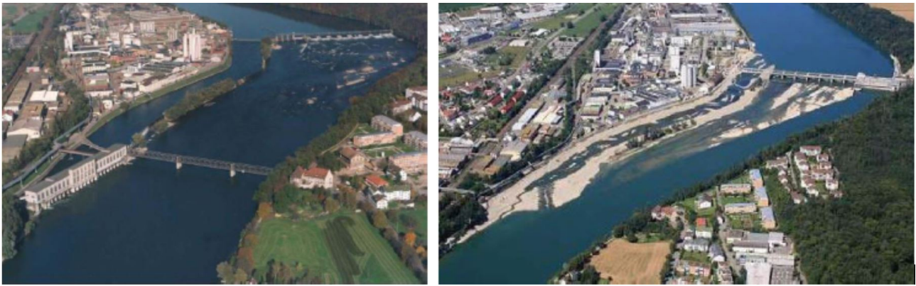
Figura 7.8 – Usina Rheinfelden (a) Antiga usina (b) Usina atual, reconstruída Fonte: WIEPRECHT, 2013
